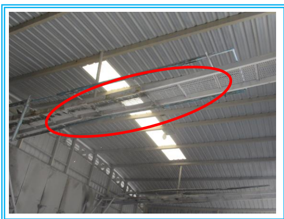
รูปที่ 3-19 ระบบสเปรย์น้ำภายในอาคาร
