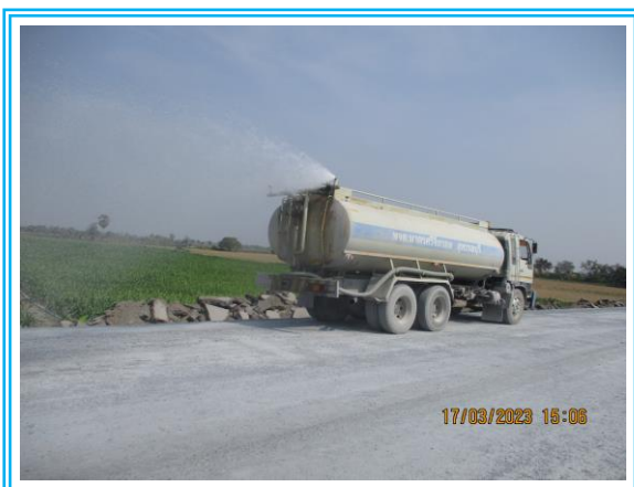
รูปที่ 3-12 (ต่อ) การฉีดพรมน้ำเส้นทางขนส่งแร่จากหน้าเหมืองถึงโรงโม่หิน
