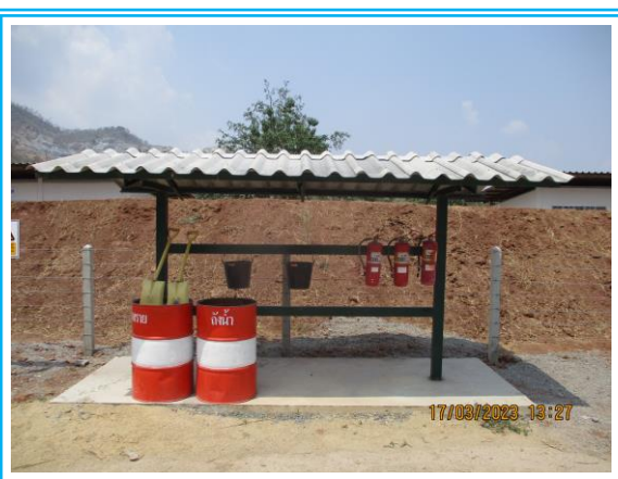
รูปที่ 3-36 อุปกรณ์ดับเพลิงบริเวณสถานที่เก็บวัสดุระเบิด
